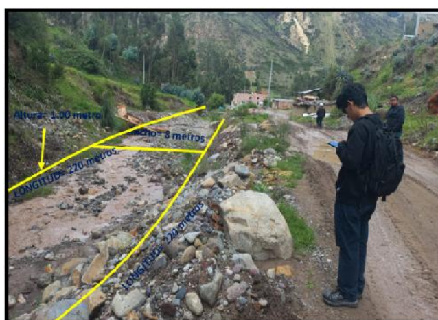
VISTA N° 2: RIO LLOCLLA – ACO CON PUNTO INICIAL E= 227136.00; N= 8933178.00 Y PUNTO FINAL E= 226940.00; N= 8933070.00, DONDE SE REALIZARA LA DESCOLMATACION DE MATERIAL DE ARRASTRE
