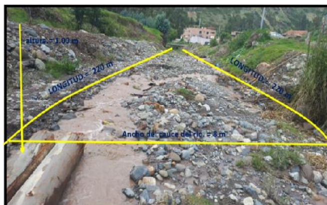
VISTA N° 5: SECTOR 1 MARGEN DERECHA DEL RIO LLOCLLA - ACO CON PUNTO INICIAL E= 227136.00; N= 8933178.00 Y PUNTO FINAL E= 226940.00; N= 8933070.00, DONDE SE REALIZARA LA CONFORMACION DE BORDO
