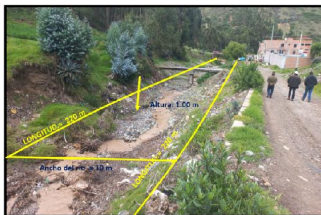
VISTA N° 6: SECTOR 1 MARGEN DERECHA DEL RIO LLOCLLA - ACO CON PUNTO INICIAL E= 227136.00; N= 8933178.00 Y PUNTO FINAL E= 226940.00; N= 8933070.00, DONDE SE REALIZARA LA CONFORMACION DE BORDO
